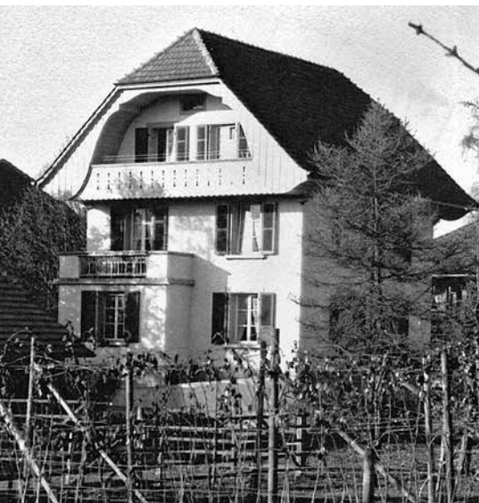
Bernstrasse 105A, Wohnhaus (Mürner-Haus), 1999. Bauherr: Johannes Mürner d.J.; Baujahr 1924.
