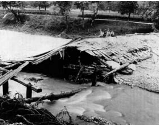
Zerstörte Schwelle, 3. August 1907
